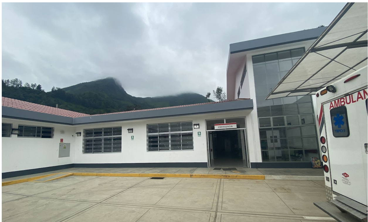
Figure 10. Centro de Salud - Canchaque (Piura)
